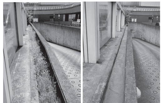
JR奈良駅構内の側溝に生えた雑草(左)の根と土を固め、青く着色した「塗るNAOS(ナオス)」で仕上げ(右)
